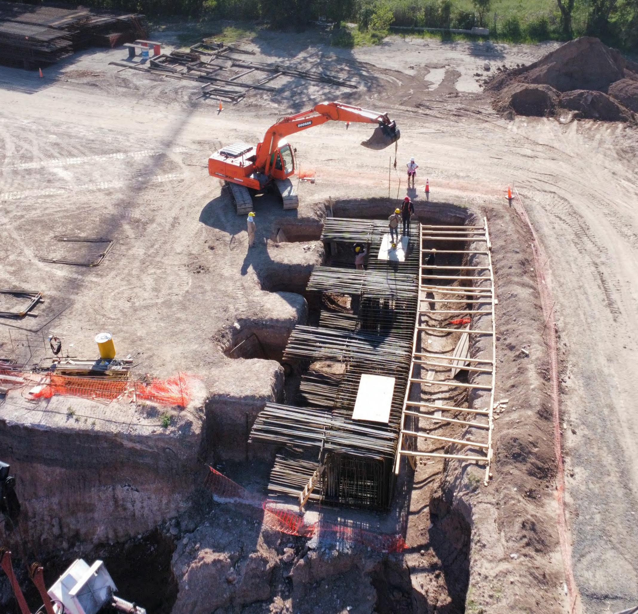
**Se trata de grandes armaduras que conectan los bloques de anclaje y módulos de las pantallas**
