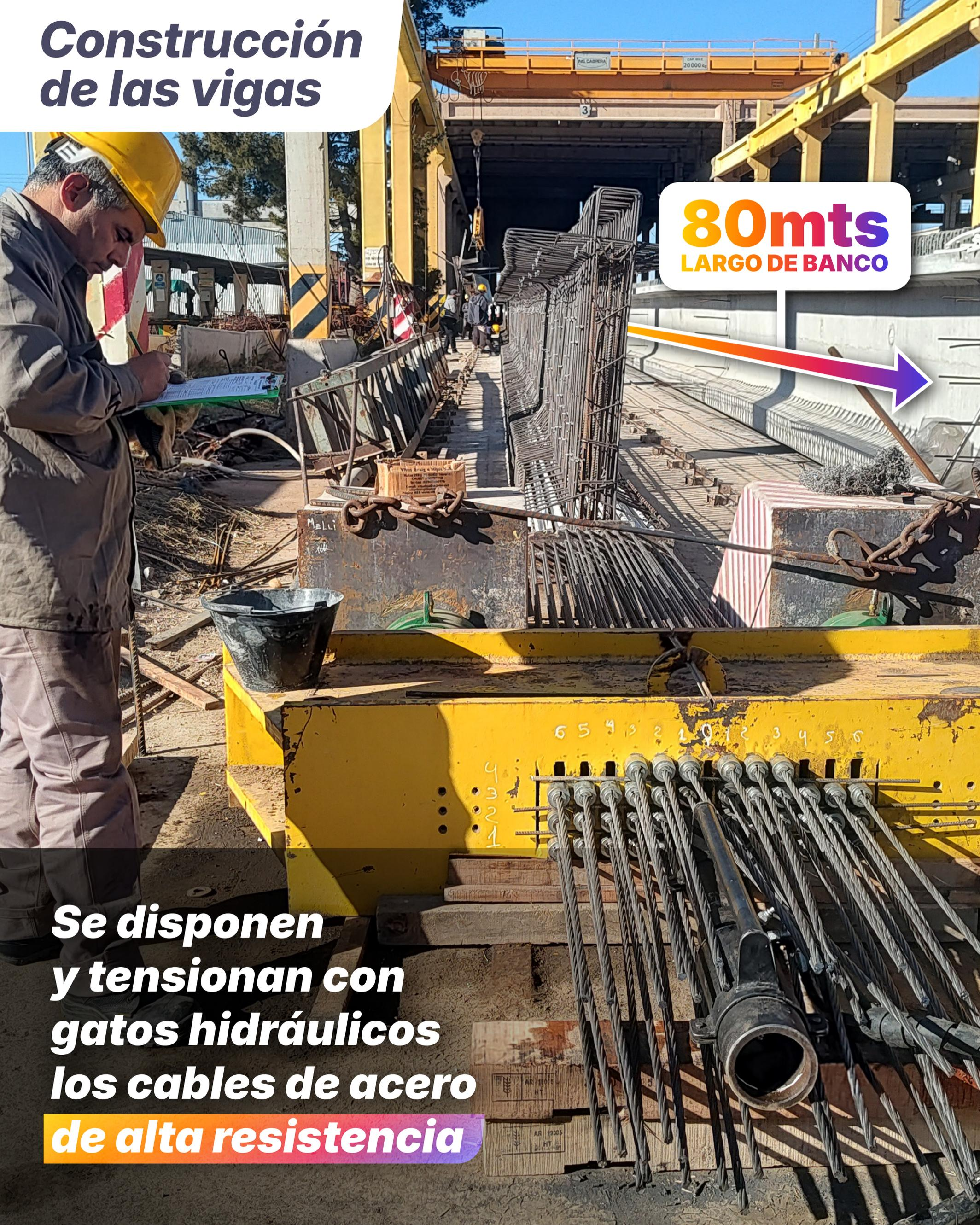
***Luego se coloca la estructura en moldes de encofrado y se vierte el hormigón***
