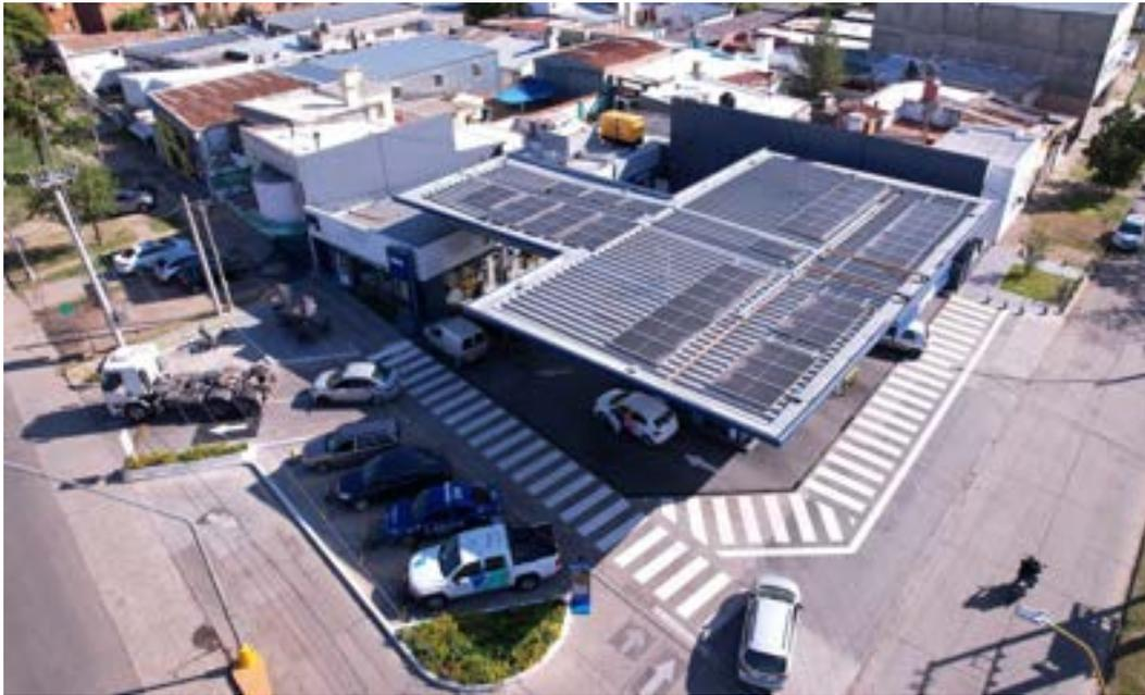
**Estación de Servicio Favini S.A.,** ciudad de Santa Fe. Instalación fotovoltaica de 23 kWp de potencia, realizada a partir del financiamiento otorgado en el marco del Plan Renovable.
