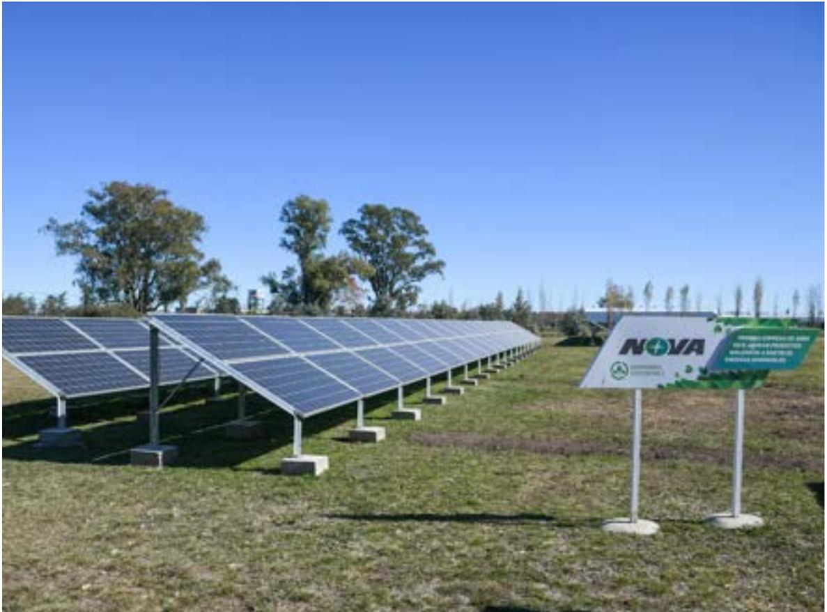
**Planta Fotovoltaica Laboratorios NOVA, en Cañada de Gómez.** Su primera etapa consta de una potencia instalada de 340 kWp, y provee de energía renovable a la planta de productos biológicos BIO NOVA, abasteciendo tanto al laboratorio como a la planta de producción que elaboran alrededor de 100.000 dosis de inoculantes por día, entre otros productos que comercializan en el mercado argentino y en otros países.
