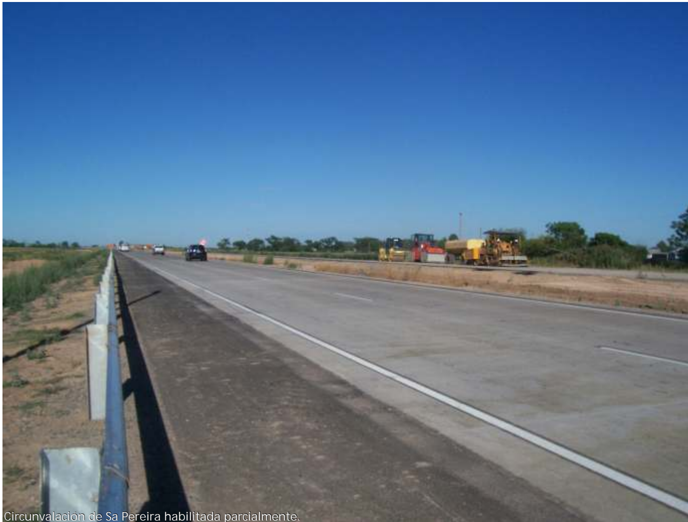
Circunvalación de Sa Pereira habilitada parcialmente.
