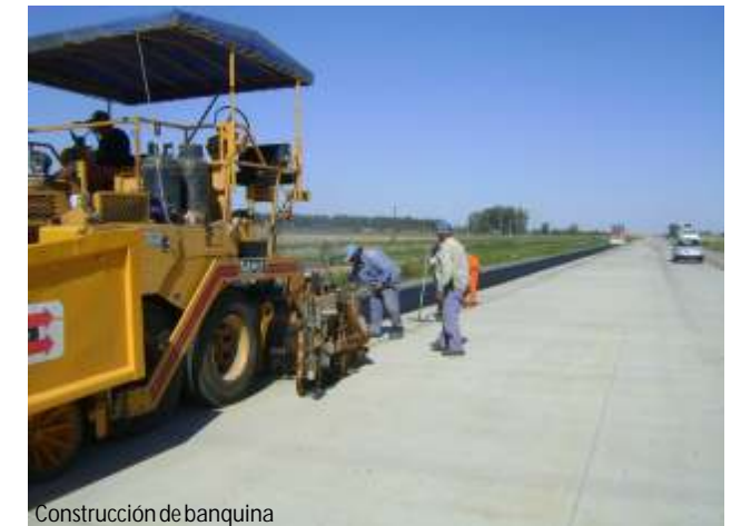
Construcción de banquina
