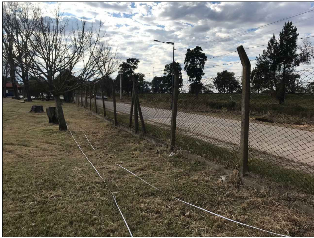
CERCO EXISTENTE DE POSTES PREMOLDEADOS Y TEJIDO ROMBOIDAL POR CALLE R. TACCA
