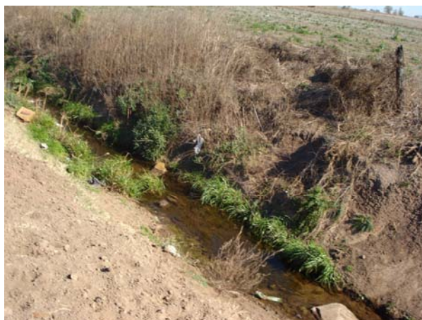
Canal Perimetral Norte, erosión en taludes, secciones en zona de Bajo.
