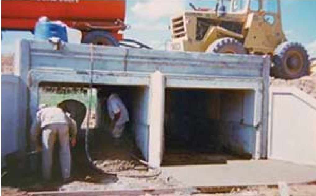
Alcantarillas de dos módulos de hormigón prefabricados.
