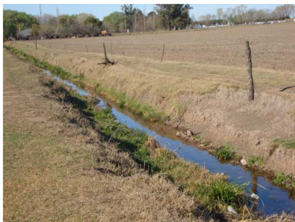
Canal Perimetral Norte, erosión en taludes, secciones en zona de Bajo.
