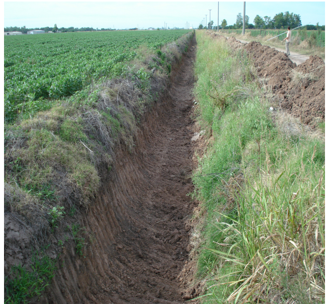
Canal cuenta Camino Rural N°26
