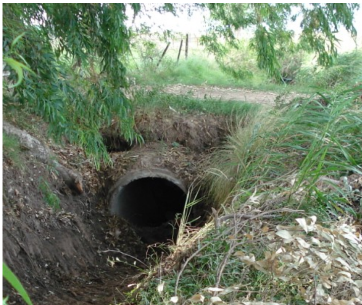
Ingreso a campos - Caños de Hº a retirar
