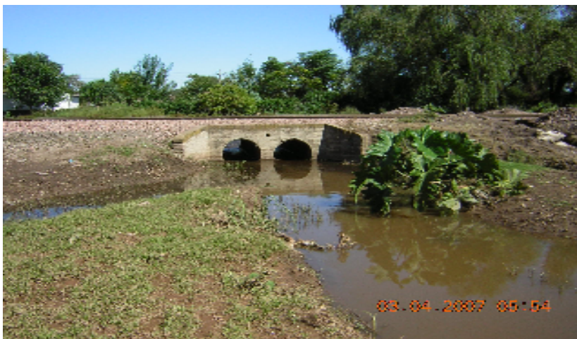
Foto 01. Alcantarilla existente cruce bajo FFCC NCA. Prolongación calle Vázquez. 2 diámetros de 1,0 m cada uno.
