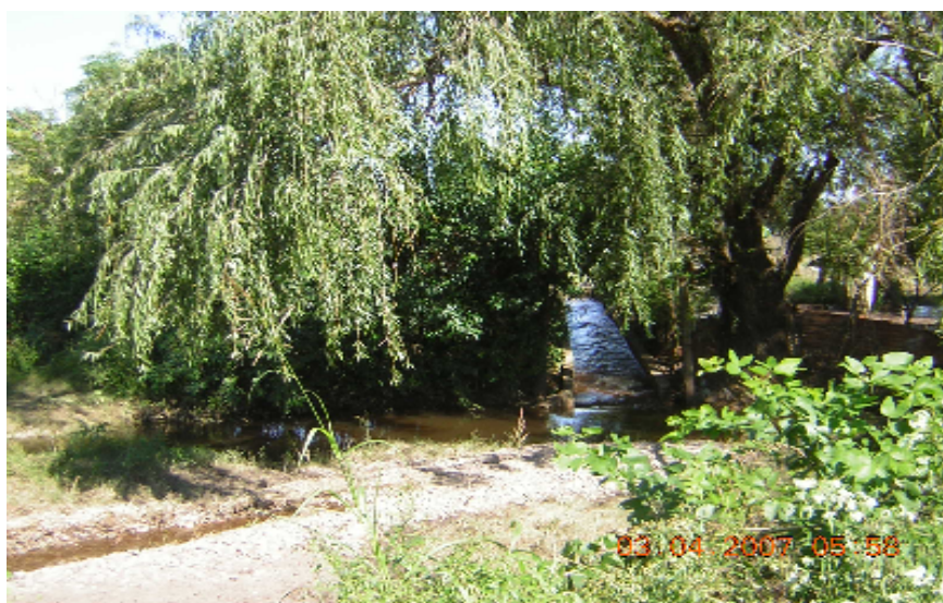
Foto 03. Canal de Mampostería aguas abajo FFCC NCA.
