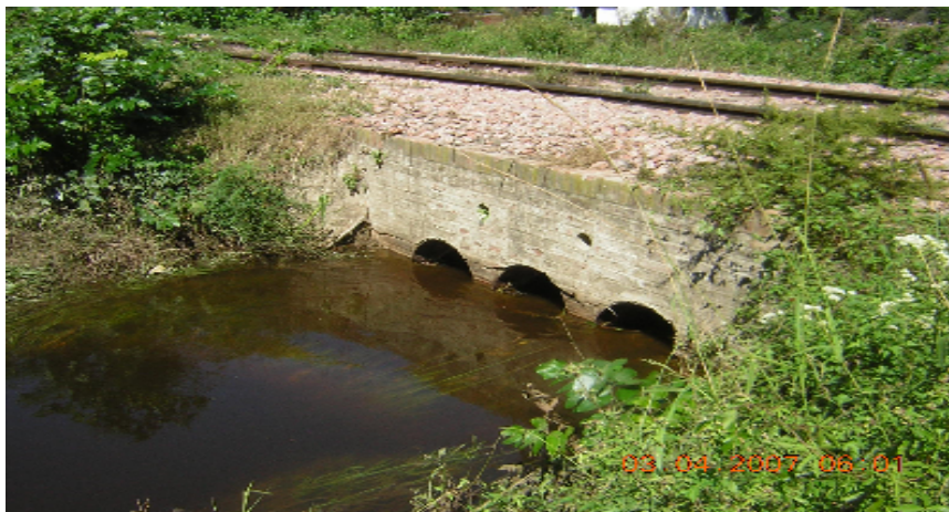
Foto 02. Alcantarilla existente cruce bajo FFCC NCA. Ubicación entre prolongación de calles Córdoba y Vázquez. 3 diámetros de 0,60 m cada uno.
