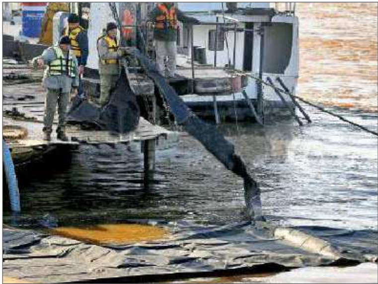
IMAGEN FECHA 21/07/2011 Llenado de los geotubos desde el barco arenero a traves de las mangas
