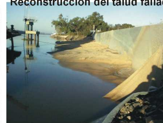
Reconstrucción del talud fallado
