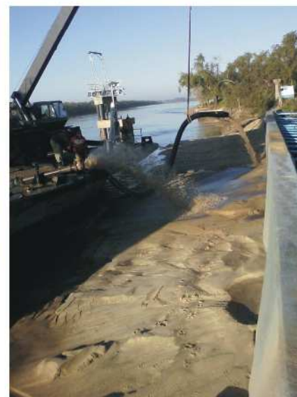
Vista del barco arena utilizado para el vertido de la hidromezcla
