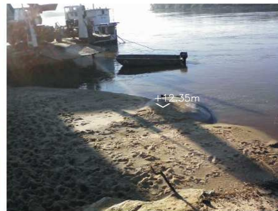
Refulado contenido por geotubos
